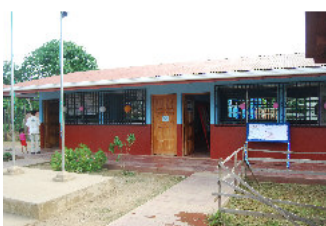
Das neue Schulhaus
